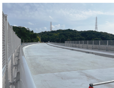
三重県四日市市 橋梁上部工[500㎡ 現場打ち]
