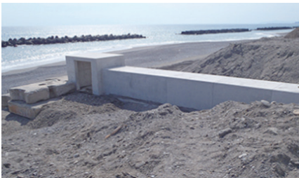
写真-2 高知県南国市 ボックスカルバート
