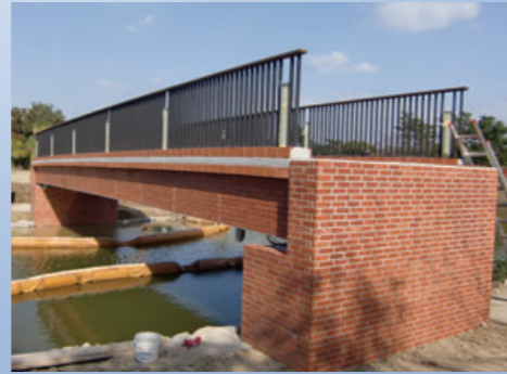
橋桁側面化粧パネル
