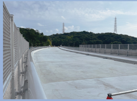
橋梁上部工(現場打ち)
